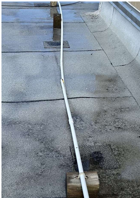
A65 – PVC Conduit on Roof
